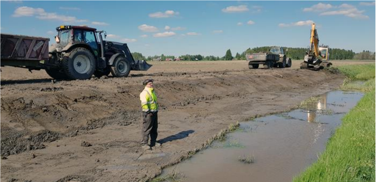
Kuva 18. Rakenteilla oleva kaksitasouoma ja toispuoleinen tulvatasanne. Kuva Satu Heino, KVVY Yhdistys.
