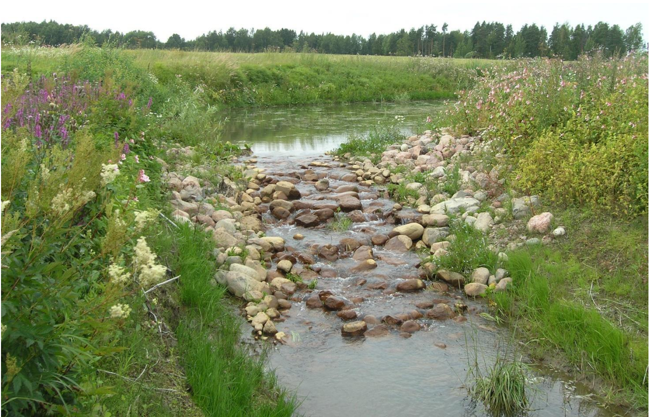
Kuva 16. Kuvassa on esitetty Hardombäckenin kunnostettua uomaa ja yksi sen luonnonmukaisista pohjapatorakenteista. Pohjakynnys sulautuu kauniisti maisemaan. Kuva Mikko Ortamala, KVVY Yhdistys.
