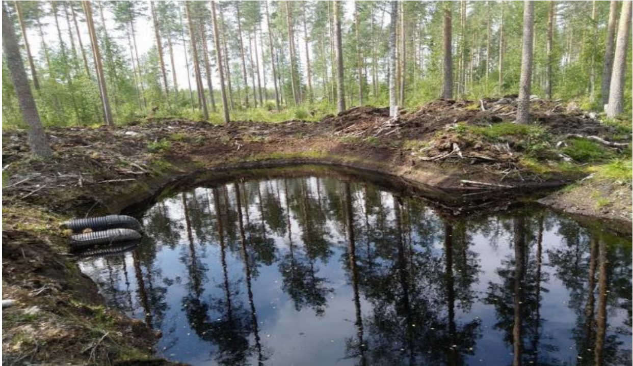
Kuva 11. Laskeutusallas, josta vedet on ohjattu eteenpäin putkipatorakenteen kautta. Kuva KVVY Yhdistys, Elina Nystedt.
