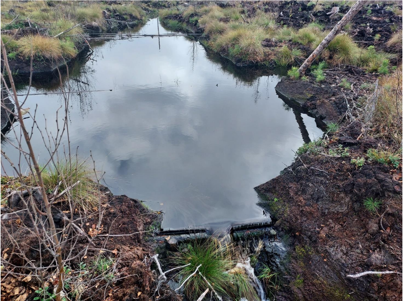
Kuva 14. V-pato, jonka yläpuolella laskeutusallas. Kuva KVVY Yhdistys, Elina Nystedt.
